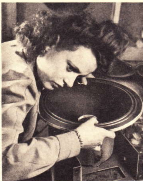
Kratzgeräusche werden mechanisch-akustisch festgestellt
